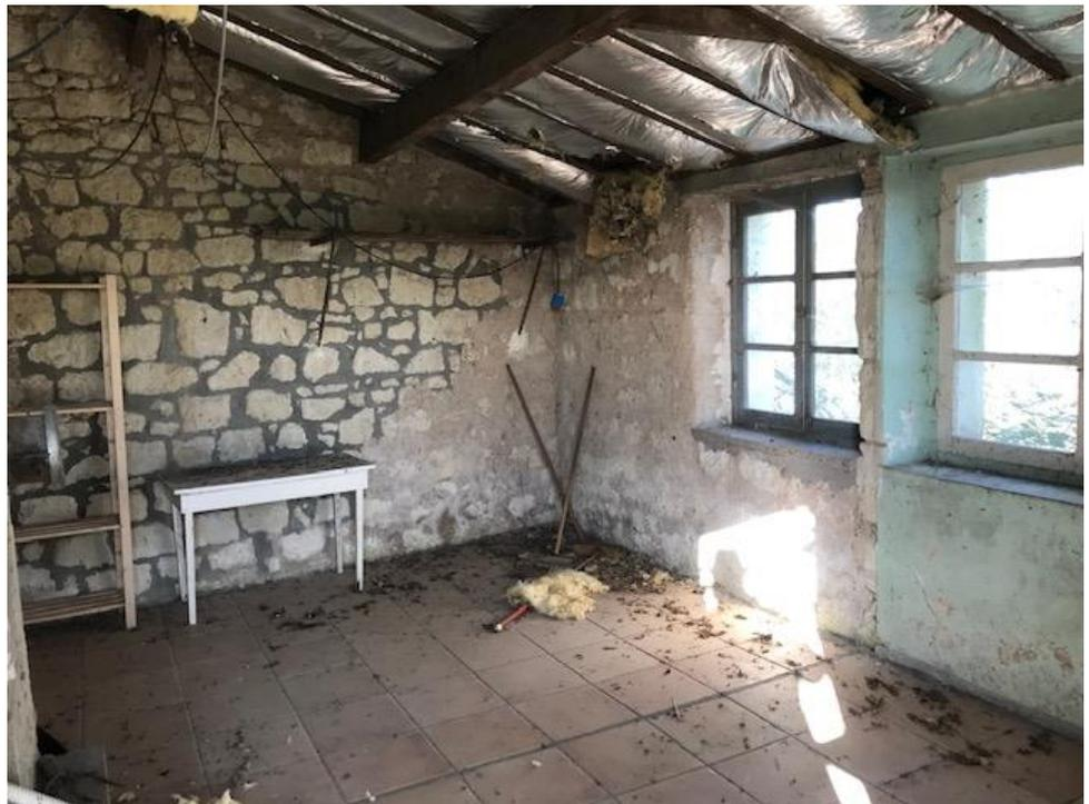
Le sol est carrelé en grès cérame ; les murs sont enduits à pierres vues avec du ciment ou du mortier bâtard.
